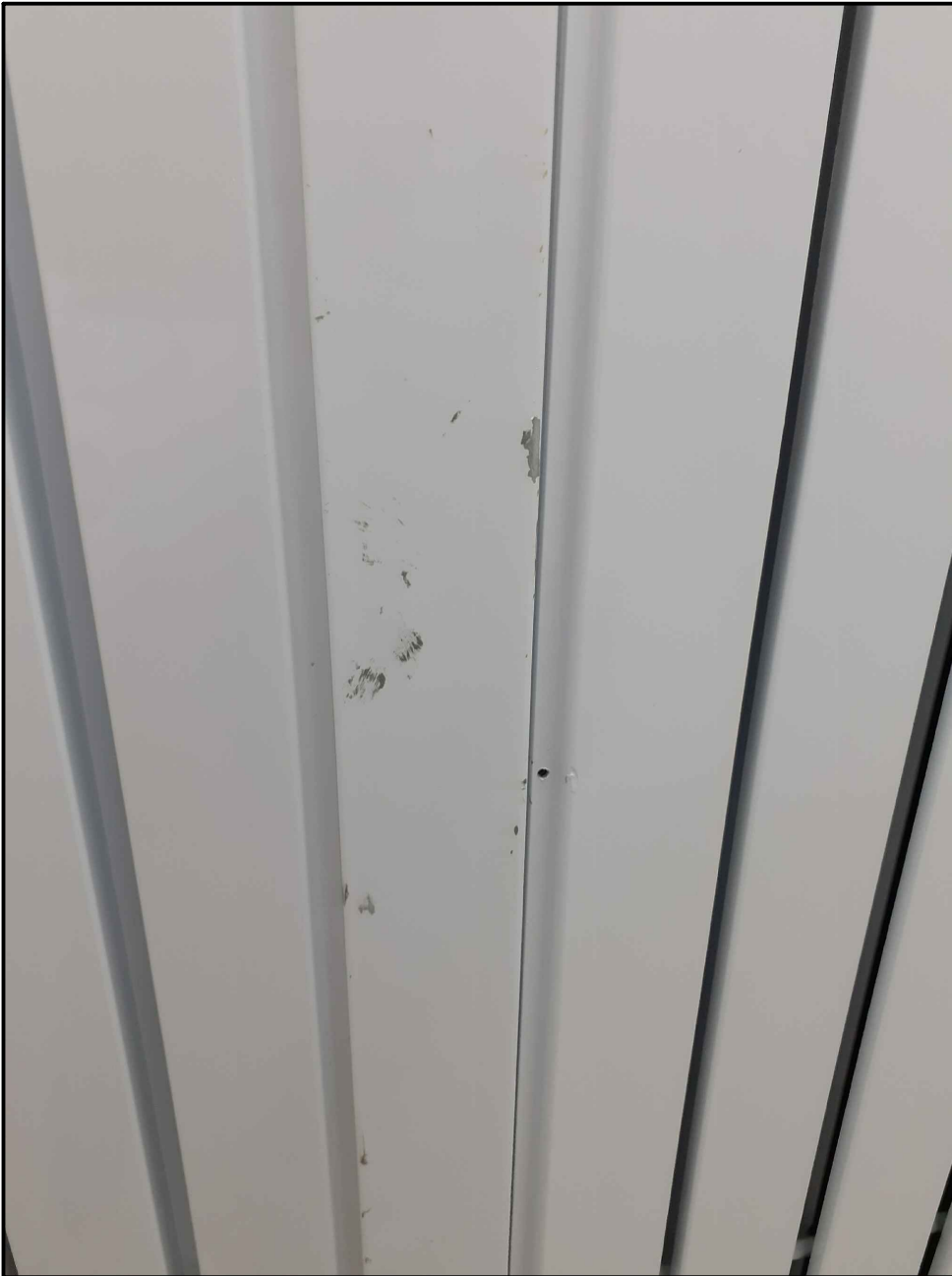
LAMBRI - MONTANTES 5º PAVIMENTO - MÓDULO 34 RECUPERAR A PINTURA DE TODOS OS MONTANTES
