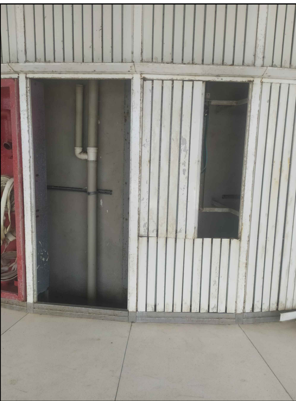
LAMBRI E QUADRO ELÉTRICO 2º PAVIMENTO REPOR PEÇA FALTANTE E RECUPERAR PINTURA
