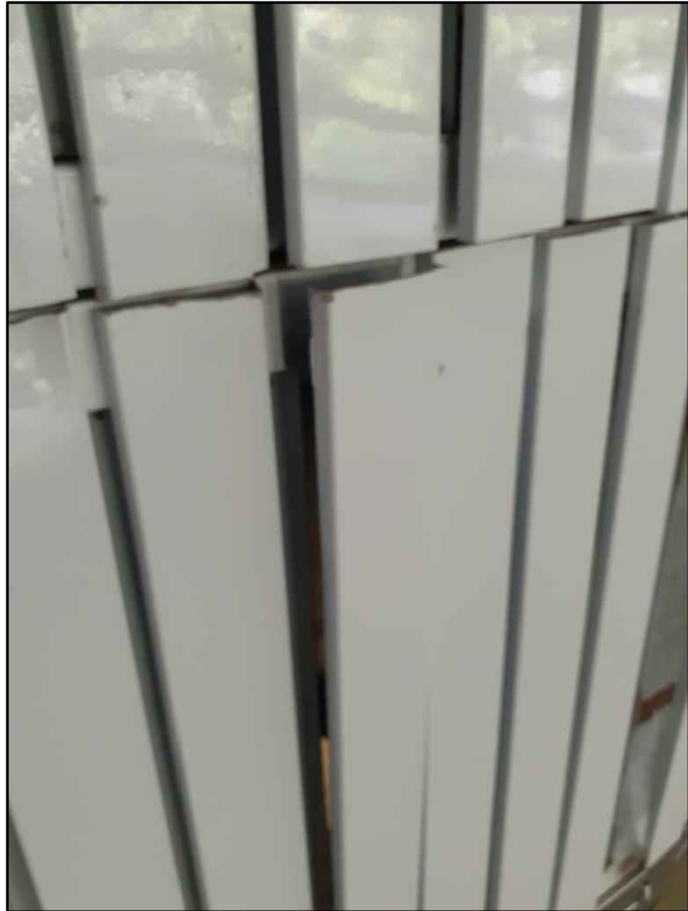
LAMBRI - QUADRO ELÉTRICO 4º PAVIMENTO - MÓDULO 4 REPOR PEÇA FALTANTE
