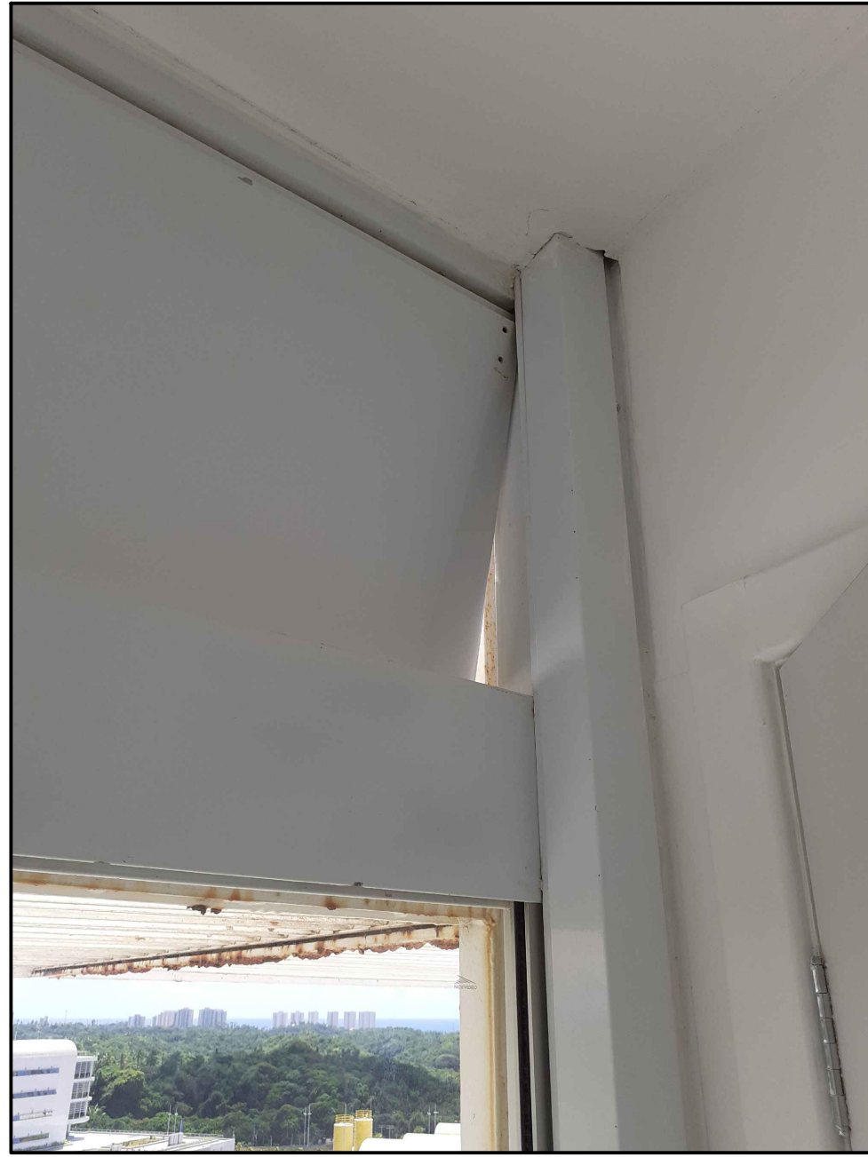
BÂSCULAS E COMNADOS 3º PAVIMENTO - MÓDULO 16 RECUPERAR BÂSCULA DANIFICADA
