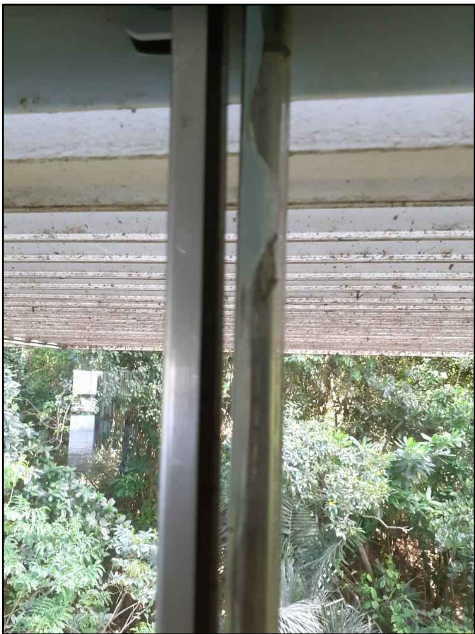
ESQUADRIA - ENGATE DOS VIDROS 1º SUBSOLO - MÓDULO 11 REVISAR A FIXAÇÃO DOS PERFIS
