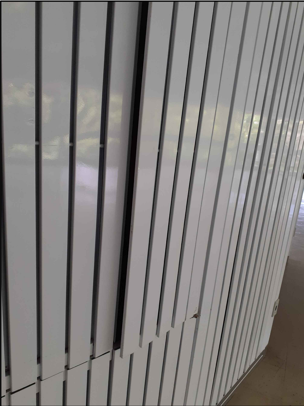
ESQUADRIA - ENGATE DOS VIDROS 1º PAVIMENTO - MÓDULO 4 REPOR PEÇA FALTANTE
