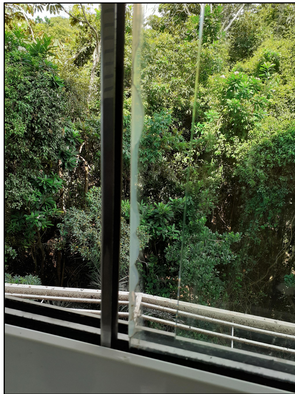
ESQUADRIA - ENGATE DOS VIDROS TÉRREO - MÓDULO 9 REPOR PEÇA FALTANTE
