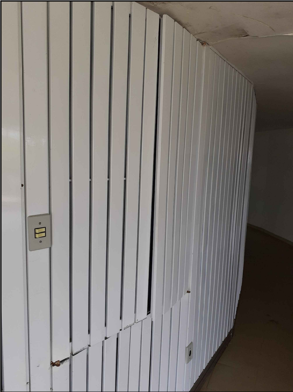
ESQUADRIA - ENGATE DOS VIDROS TÉRREO - MÓDULO 4 REPOR PEÇA FALTANTE
