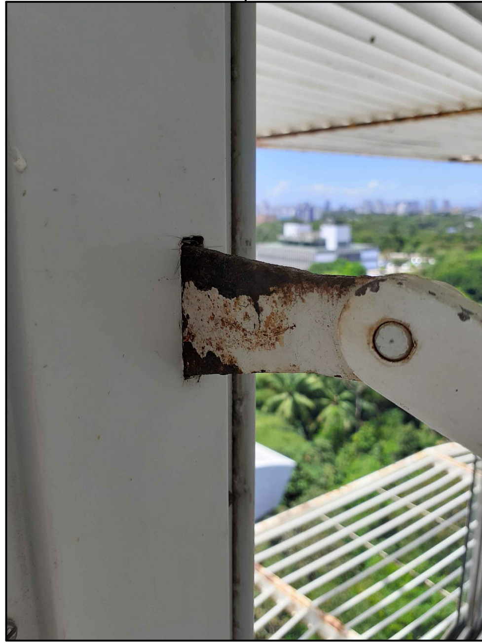
BÂSCULAS E COMNADOS 5º PAVIMENTO - MÓDULO 10 RECUPERAR PINTURA DOS COMANDOS
