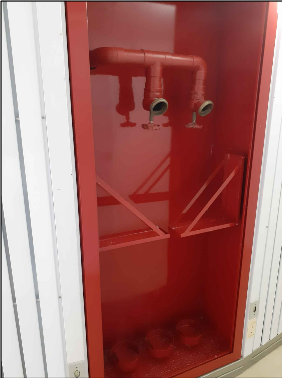
LAMBRI - ARMÁRIO DE INCÊNDIO 5º PAVIMENTO - MÓDULO 25 INSTALAR VIDRO NO ARMÁRIO DE INCÊNDIO
